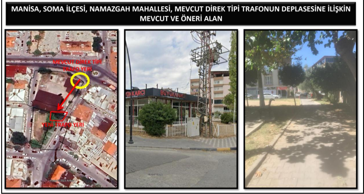
Foto-2: Mevcut ve Öneri Trafo Alanı
